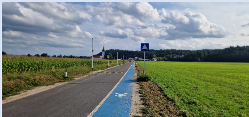
Ureditev novih varnih površin za pešce (Foto: arhiv LUZ)
