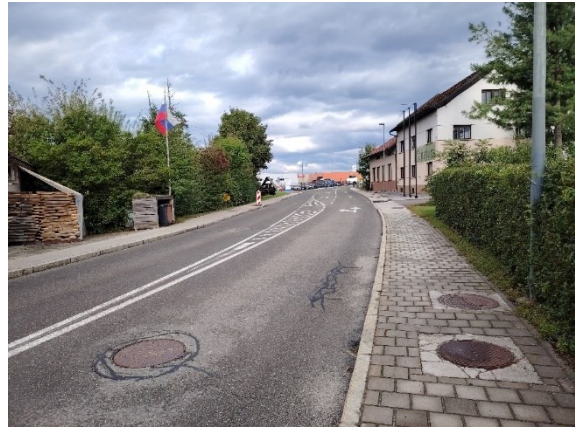
Slika 2: Pogled z Gorenjske ceste proti severu, območje OPPN je z zelenjem porasla leva stran ceste (vir: lasten, sept. 2024)
