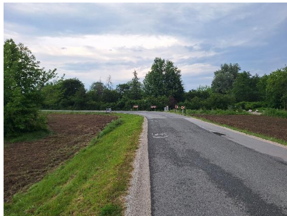
Slika 7: Pogled na oster ovinek na lokalni cesti Mengeš – Vodice (foto: maj 2026, vir: lasten)
