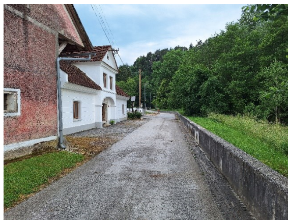
Slika 7: Obstoječi protipoplavni zid (foto: maj 2026, vir: lasten)
