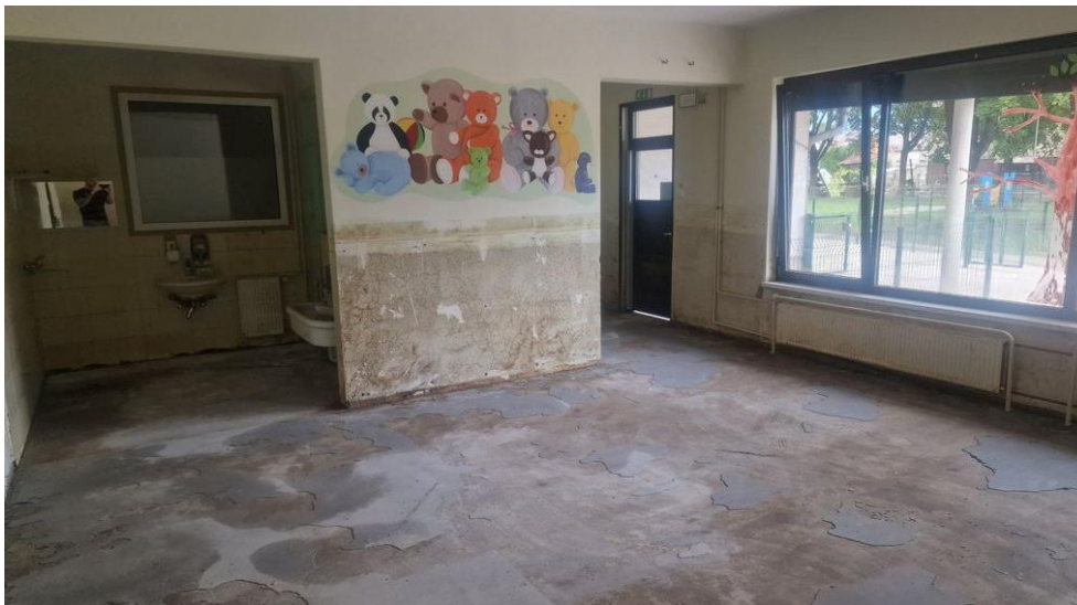
Slika 4.2: Obstoječe stanje prostorov enote Gobica
